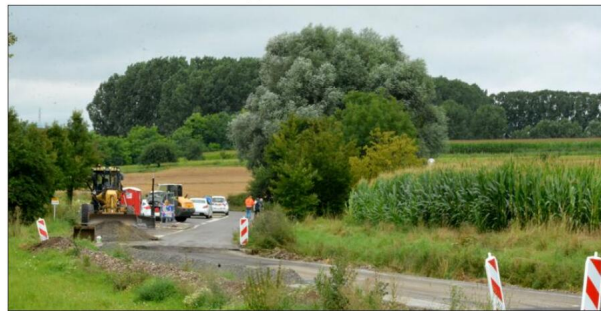
La réhabilitation de cette route classée en catégorie 3 au schéma départemental routier, c'est-à-dire voie de desserte, devenait nécessaire pour les usagers et les professionnels de plus en plus nombreux à l'emprunter. Photo DNA/G.E.
